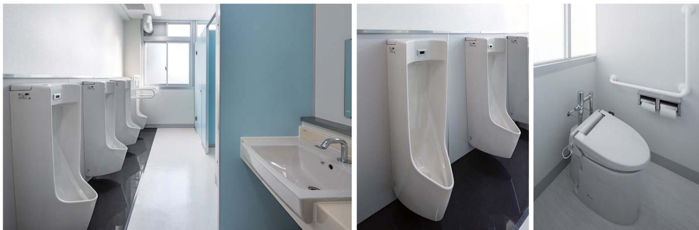
開口部からの採光を活かした明るいトイレ空間。節水効果の高いセンサー一体型小便器や自動水栓の採用により、環境負荷低減にも貢献している。小便器はすっきりしたデザインで清掃性にも優れた壁掛けタイプ。手すりを設置した大便器ブースも設け、利用者の安全にも配慮している。
