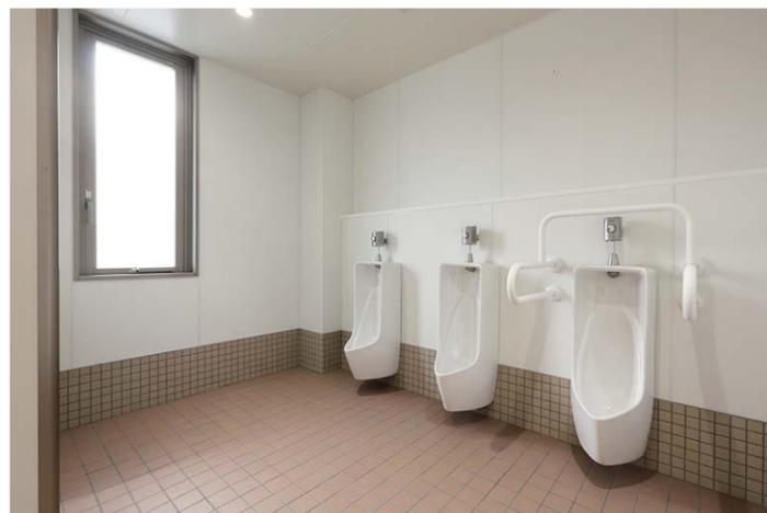
明るく清潔な利用しやすいトイレ。手洗器には水石けん入れを設置している。災害時に避難施設として利用されることを考慮し、大便器は断水時にバケツ洗浄ではなくタンクに給水して利用可能なタンク式とした。暖房便座を採用し、屋外でも快適に利用できる。
