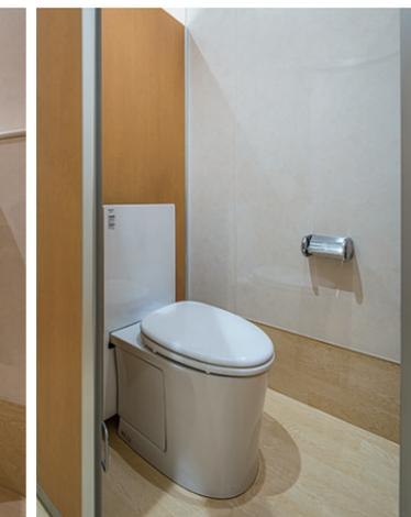
小便器は凹凸の少ない壁掛タイプで清掃性に貢献。大便器は露出するとゴチャゴチャした印象になる止水栓などをタンクの背面・アンダーカバーの内側に隠して空間すっきり。フチレス形状で掃除もしやすくなっている。
