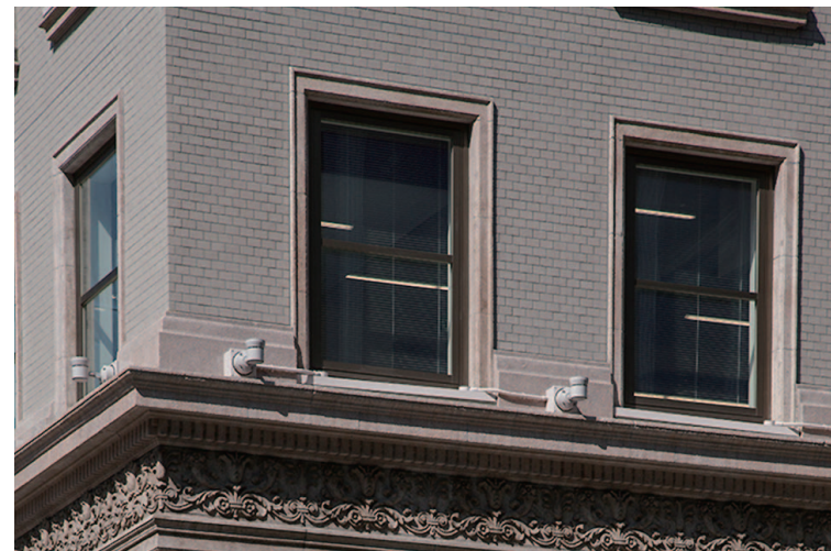
開口部外装壁面
