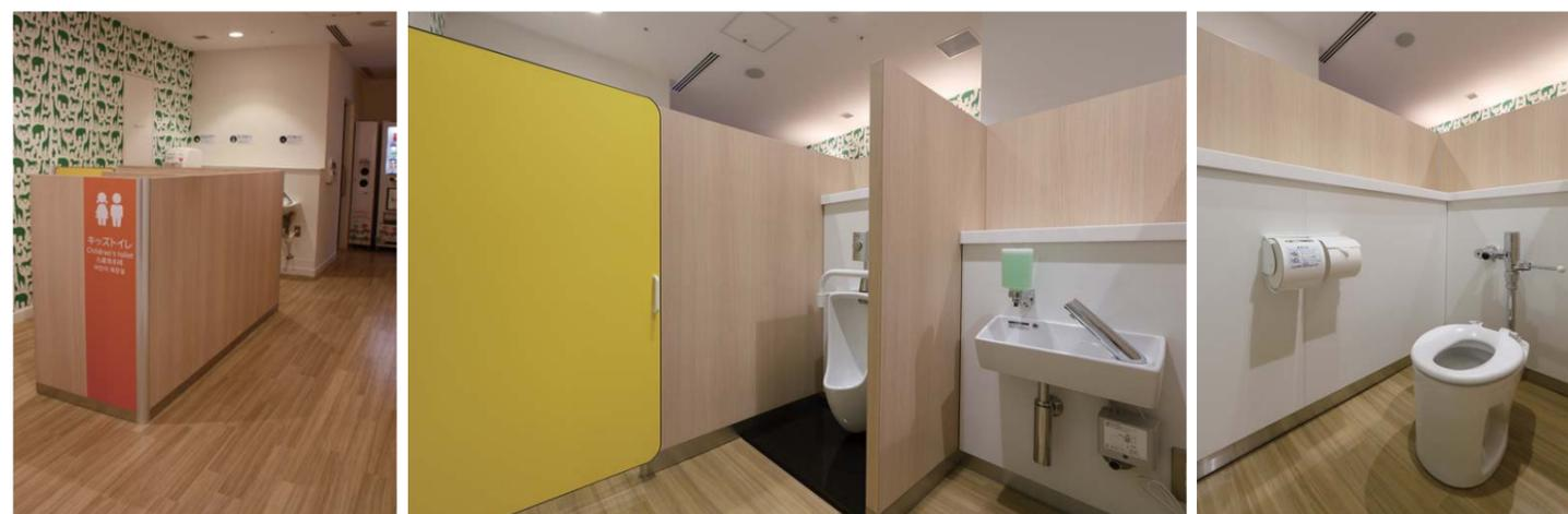
ベビー休憩室とオムツ替えコーナーにキッズトイレを併設。キッズ専用トイレなら家族で一緒に利用できる。ブースは保護者が見守れる高さで安心。洗面器は非接触の自動水栓の採用で節水と衛生面に配慮。使用器具の高さや子どもの使いやすさに配慮し、広めのブースには通常より低い高さの幼児用大便器・幼児用小便器を設置。
