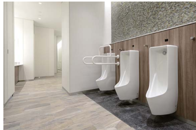
節水性に優れ、清掃性も高い壁掛式のストール小便器を採用。手すりを設け、様々なユーザーに配慮している。小便器エリアのライニング部分に設けられたフックも利便性の高いアクセサリ。男性用トイレ内にもベビーキープを設置したブースを設け、子ども連れの男性も安心して利用。
