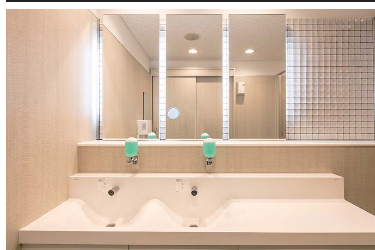
女性用トイレには演出性の高い温白色の照明を採用。洗面カウンターにはドライエリアを確保し、荷物置き場に配慮。3連カウンターは2箇所を洗面とし、1箇所をパウダーコーナーにしている。全身がうつる姿見を配置し身だしなみの最終チェックができるようになっている
