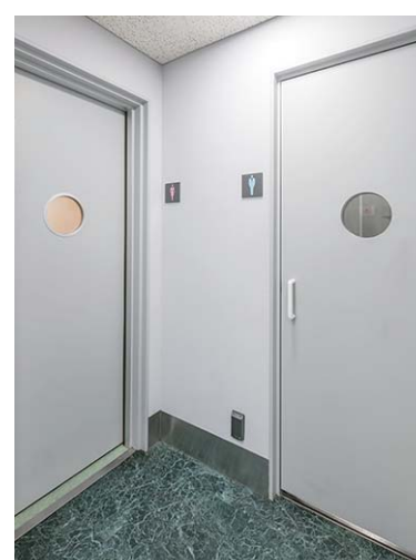
女性用トイレには引き戸を採用し限られたスペースを有効に使っている。
