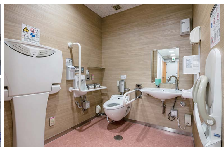
ベビーシートやベビーキープを設置しているので、車椅子利用の方だけでなく、子ども連れの方も安心して利用できる空間になっている。
