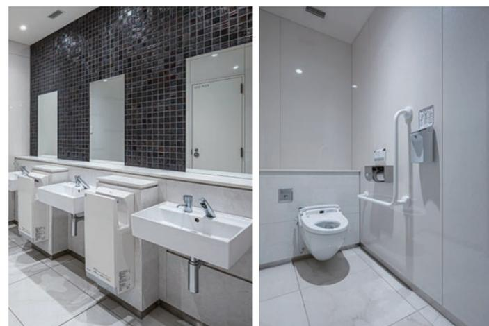
洗面器に隣接して交互にハンドドライヤーを配置することで、移動時の水垂れを最小限に抑えられる。便器には掃除のしやすい壁掛け式を採用し、清掃性を高めている。
