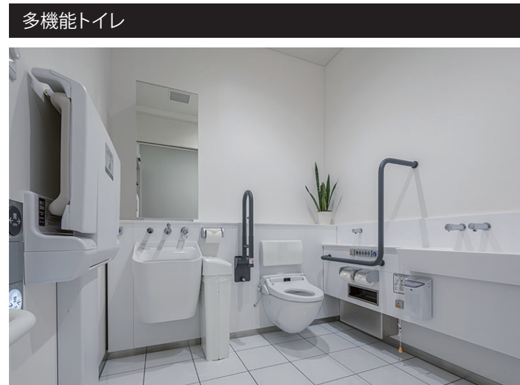
ライニングとバックガードのストレートなラインならびに水栓金具・水石けん入れ・紙巻器の配置高さを揃え、すっきりとした印象の多機能トイレ。立ったままのおむつ替えに配慮し、チェンジングボードには手すりを設置している。
