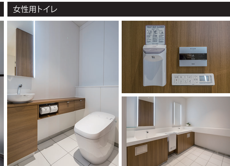
ブース内に手洗カウンターとフロント照明付鏡を設置し、個室感を演出。サウンドデコレーターのせせらぎ音と天井まで伸びた仕切り板でプライバシーを守っている。
