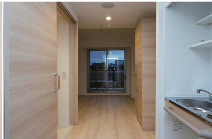
ミニキッチンが付いたタイプの居室プラン。ミニキッチンは車椅子や椅子に座って作業がしやすいシンク下にキャビネットが無いタイプを採用。このタイプの居室プランの洗面台は大便器の正面に配置されており排泄後の手洗い行為までの動線が短くなるように配慮されている。(左上写真)
