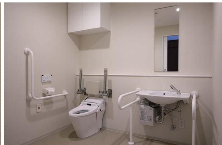
広めの空間に、車椅子対応のセンサー一体型大便器を設置。L型手すりや洗面器
