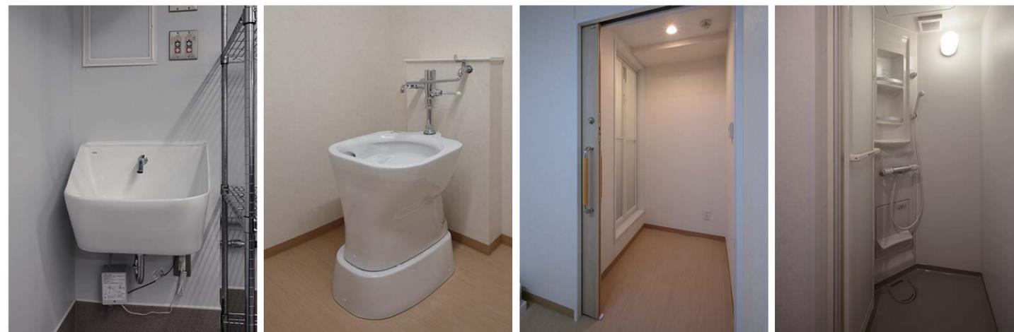
調理スタッフの手洗用に、肘から洗える 失禁などの後始末に、汚物流しとシャワーユニットが設置された洗濯室。汚物流しは手が汚れていても肘などで操作も可能な鉢の深い手洗器を採用。 汚物流しは手が汚れていても肘などで操作も可能なレバーハンドルの水栓を採用。
