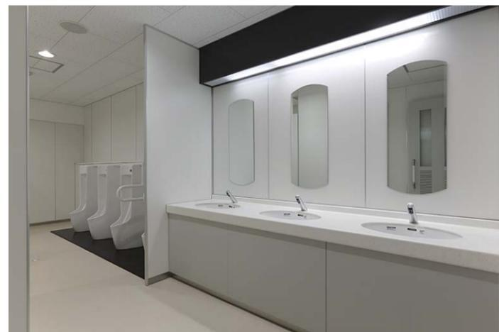
洗面カウンターは非接触の自動水栓を採用することにより、使用者の衛生面と使いやすさに配慮。センサー一体形小便器は、洗浄水量わずか1Lという優れた環境性能を実現。怪我など身体が不自由な時に体を支えられる手すりを設置している。
