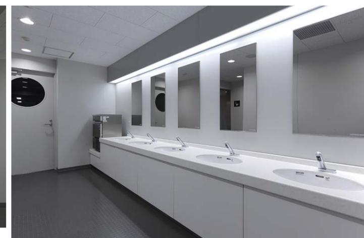
洗面カウンターは非接触の自動水栓を採用することにより、使用者の衛生面と使いやすさに配慮している。個別鏡なので隣の視線が気にならず落ち着いて利用できる。
