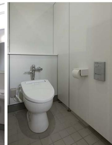
個室が両側に並び、奥に洗面台が設置され、その先が出口へ繋がっている。ブースの扉には使用状況がわかるようなサインを取り付け、スムーズに利用できるよう配慮している。擬音装置の設置により音消しのための洗浄を防ぎ、水のムダ使いを減らす。洗面器には非接触の自動水栓を採用し、使用者の衛生面と使いやすさに配慮。
