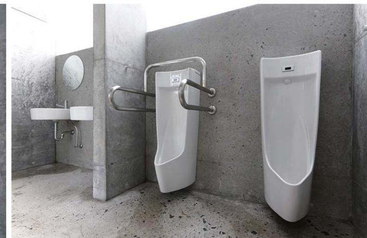
小便器は床の清掃がしやすい壁掛けタイプを採用。パブリック空間で気になる衛生面に配慮したセンサー一体型で、流し忘れも防止する。
