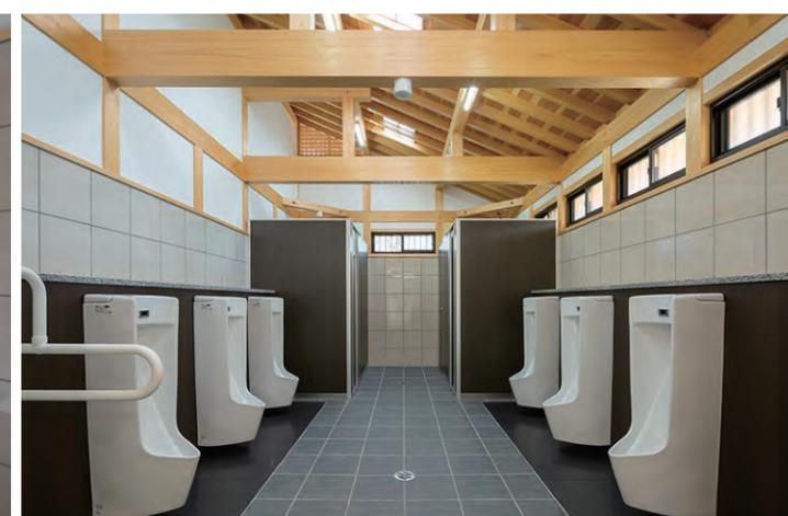
小便器は壁掛式でシンプル形状のセンサー一体型を採用。尿垂れを考慮した汚垂石を便器下に設置することで、床の清掃性を向上させている。
