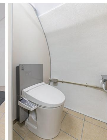
窓から自然光を取り入れ、天井や壁の曲線が広がりを感じさせる室内。壁掛タイプの小便器と便器下の汚垂石が床の清掃性を高めている。クイックタンク式床置便器は洗浄間隔が約20秒と短く、利用が集中しても待ち時間なくトイレを使用することができる。
