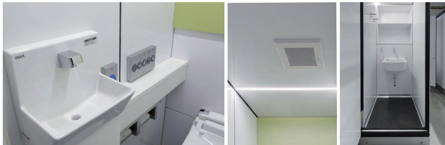
各個室に手洗いを設け、洗面へ移動しなくても1箇所ですっきり済ませることができる。自動水栓による節水は環境負荷軽減にもつながっている。また、照明や換気扇は人感センサーで自動的にオン・オフするので、スイッチ操作の必要がなく消し忘れを防止。トイレ内には掃除用流しも備え、いつでもトイレ内を清潔に保つことができる。
