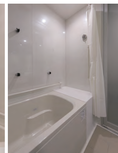
移乗スペース付浴槽
