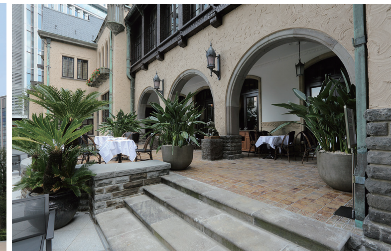
テラス外装床面
