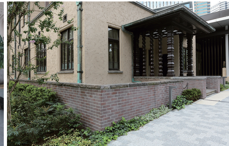
外溝擁壁部外装壁面
