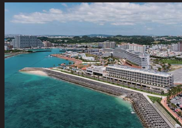
撮影：小林・川澄研二写真事務所 外観全景
