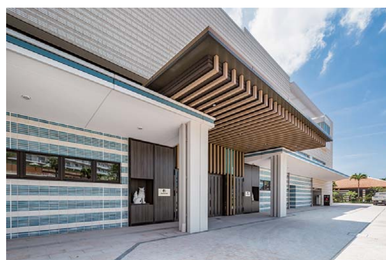
入口外装壁面
