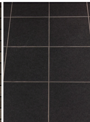
エレベーター床タイルディテール
