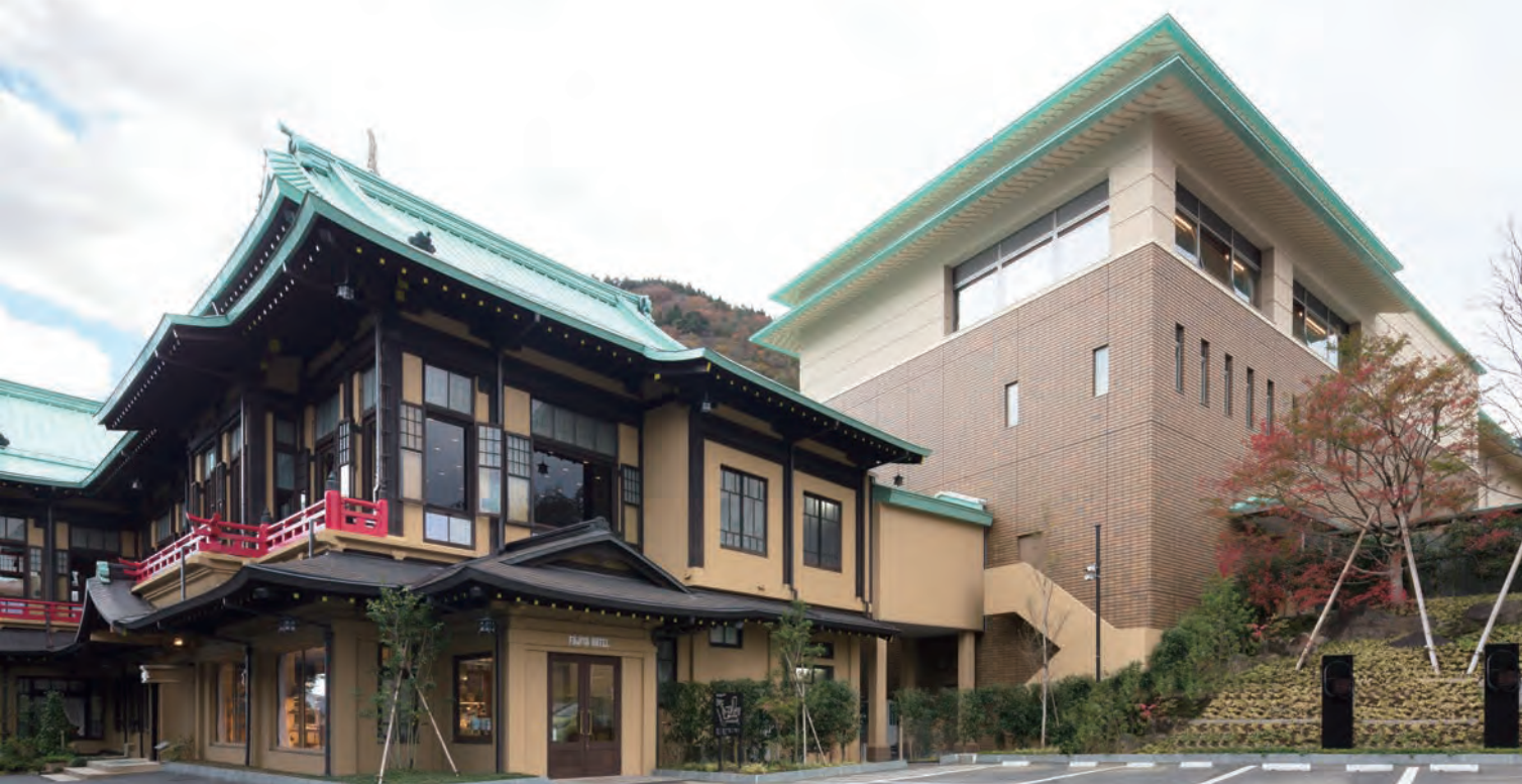
登録有形文化財の食堂棟と接続されたカスケードウイング外観
