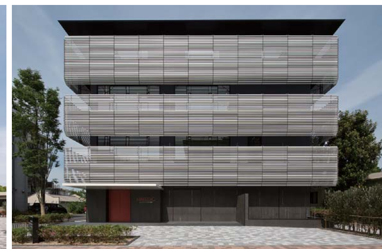
東側外装壁面
