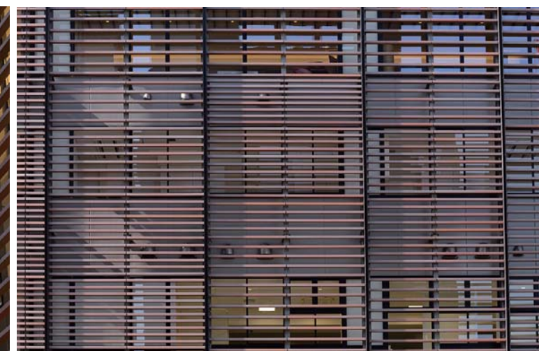
開口部外装壁面
