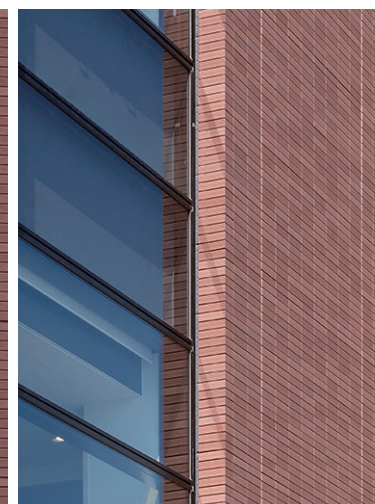
外装壁面(開口部)
