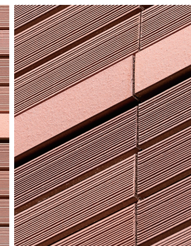
壁面タイルディテール(見上げ)
