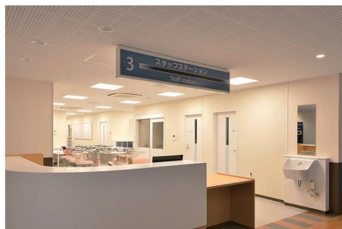
入り口には手首までしっかり洗える大型手洗器を設置。深い鉢を採用しているため、鉢底面や側面に指先が当たりにくく、衛生的に使用できる。
