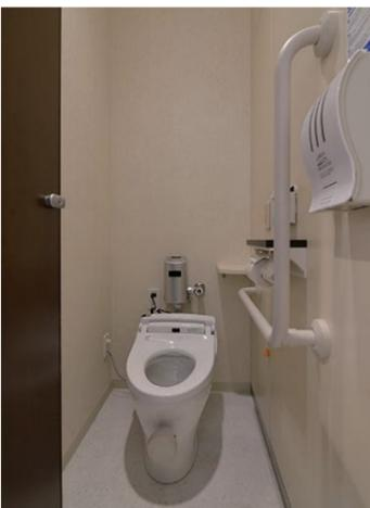
洗面空間は白を基調とした清潔感を感じさせる内装。壁掛式で非接触式のセンサー一体型便器は衛生的で清掃性にも優れている。
