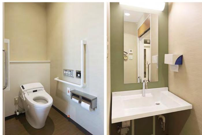
トイレには手すりや呼び出しボタンを設置し、安全面に配慮。洗面カウンターは車椅子でも利用しやすく、自動水栓を採用し非接触で吐水・止水できる。
