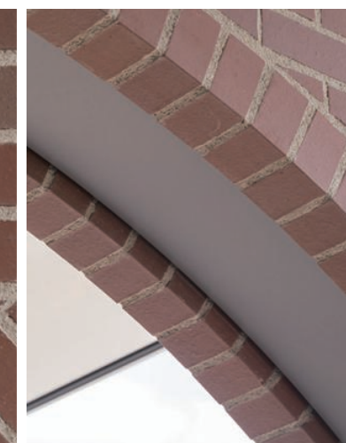
外装壁面アーチ部
