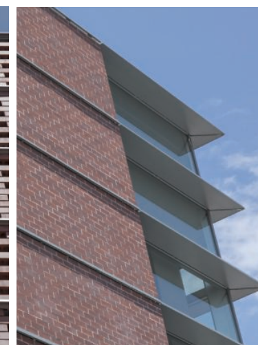
外装壁南東面
