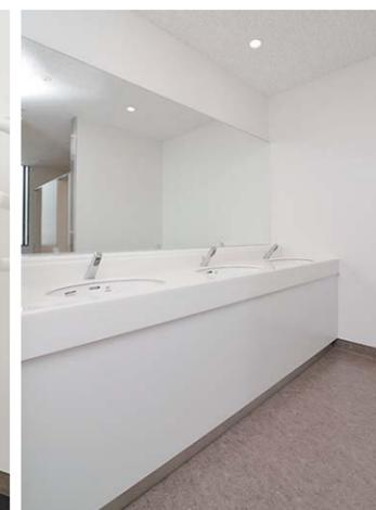
洗面台にはアンダーカウンター式洗面器に高い節水性を誇る自動水栓が備えられた。
