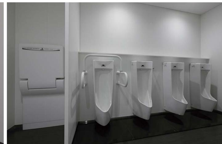
アンダーカウンター式の洗面器でカウンターの奥行きをコンパクトにしながゆったりとした内寸を確保。非接触の水栓を採用し、利用者に清潔感と快適性を提供している。小便器は洗浄水量わずか1Lという優れた環境性能を実現したセンサー一体型小便器。シンプル形状・壁掛式で清掃性に優れている。
