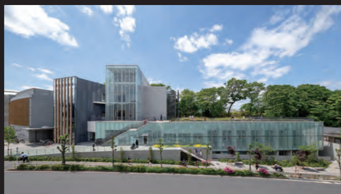
北側外観全景左端は既存管理棟
