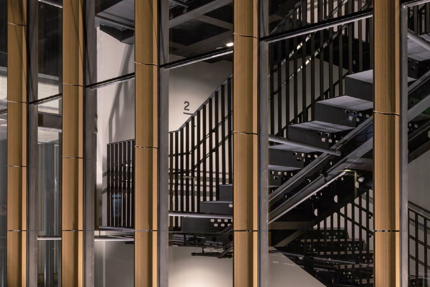
ライトアップされるテラコッタルーバーと屋内階段
