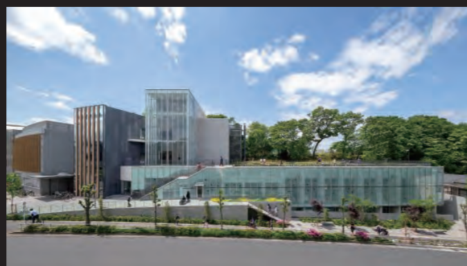
北側外観全景左端は既存管理棟
