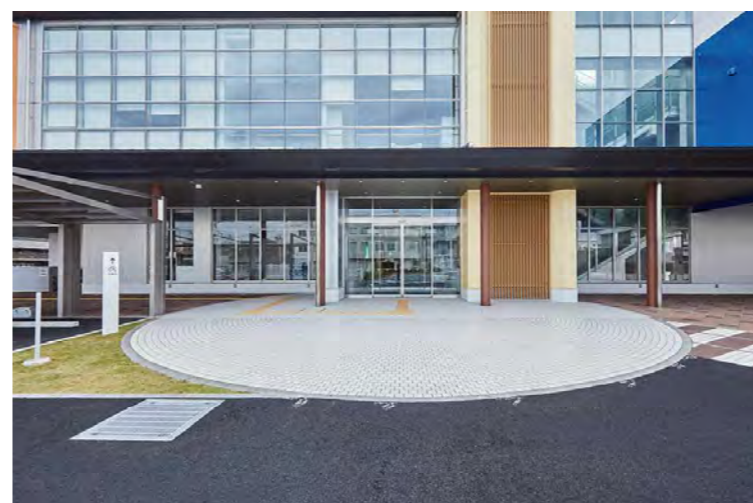
中央玄関全景
