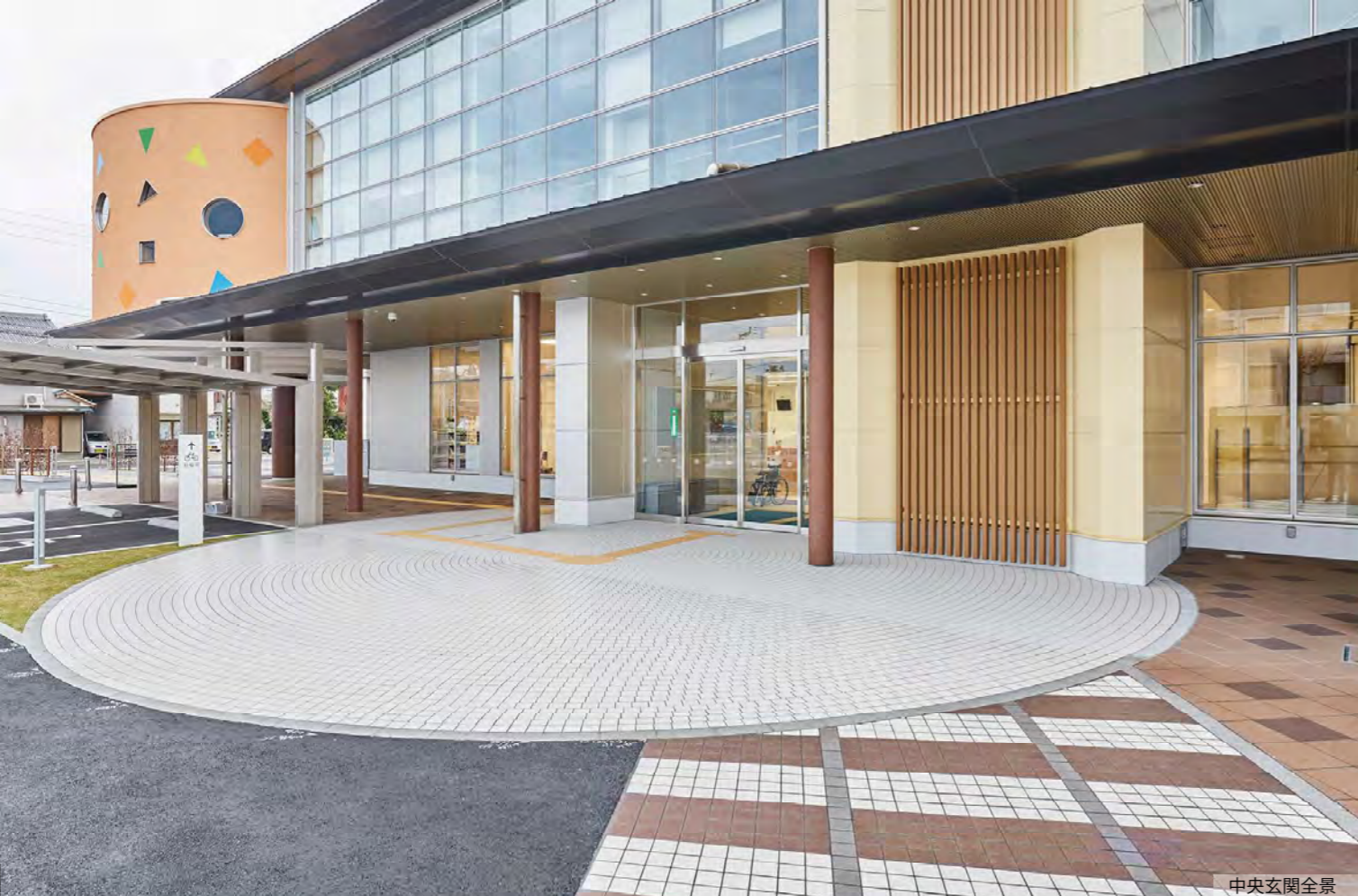
中央玄関全景
