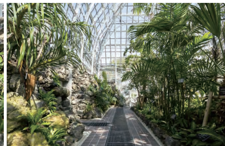
内装床面側溝部
