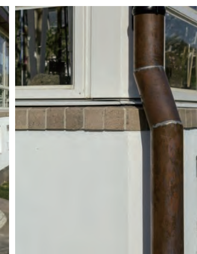
外装壁面台コーナー部
