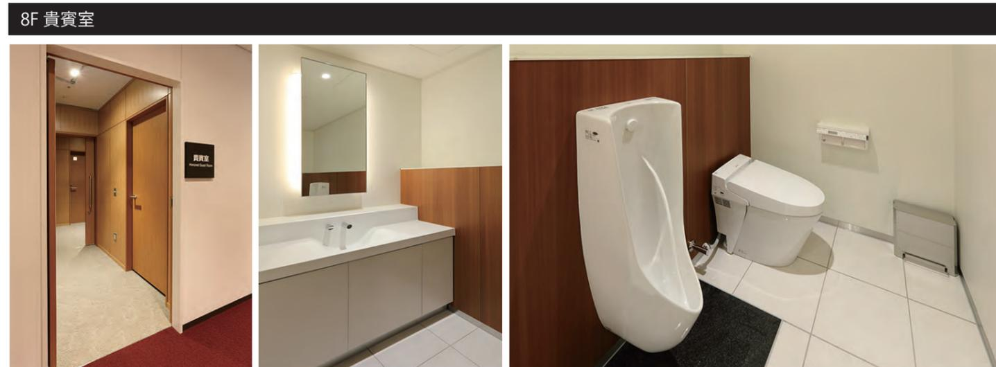
貴賓室には小便器も備えた個室タイプのトイレを設置。洗面カウンターは手荷物をしっかり置くことができるシェルフを備え、ゆったり手洗いができる。壁付けの自動水栓と水石けんは吐水口周辺に凹凸が少なく、水平基調の形状が建築空間と調和している。
