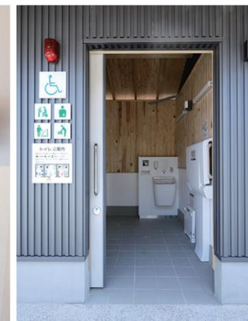
車椅子やベビーカーでもスムーズに利用できる広いブース内にはオストメイト、おむつ交換台、ベビーキープ、チェンジングボードと機能が充実している。また緊急呼出しボタン、停電時操作ボタンや、操作する度に発電する電源不要の独立型リモコンなど、万が一に備えた設備も設置。便器は掃除口付きで清掃性にも配慮されている。
