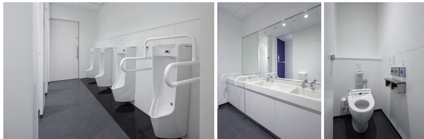
小便器、大便器は節水に効果があるセンサー式を採用。小便器下には尿垂れに配慮し汚垂石を設置。大便器ブース内のリモコンは大きくわかりやすいボタンで視認性が高く、外国語による案内表示付き。また各所に手すりが設けられており、誰もが安心して利用できるよう配慮されている。
