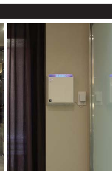
ベッドルーム (プラズマクラスター空気清浄機能付給気口「クレールFan」)
