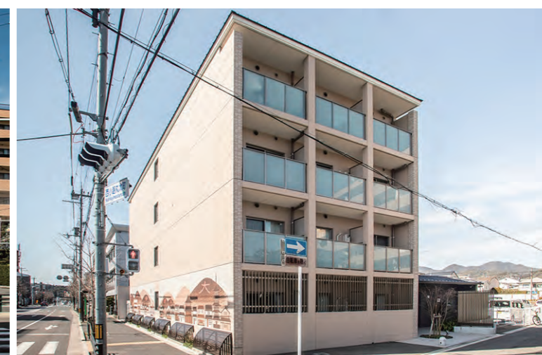
交差点側外装壁面
