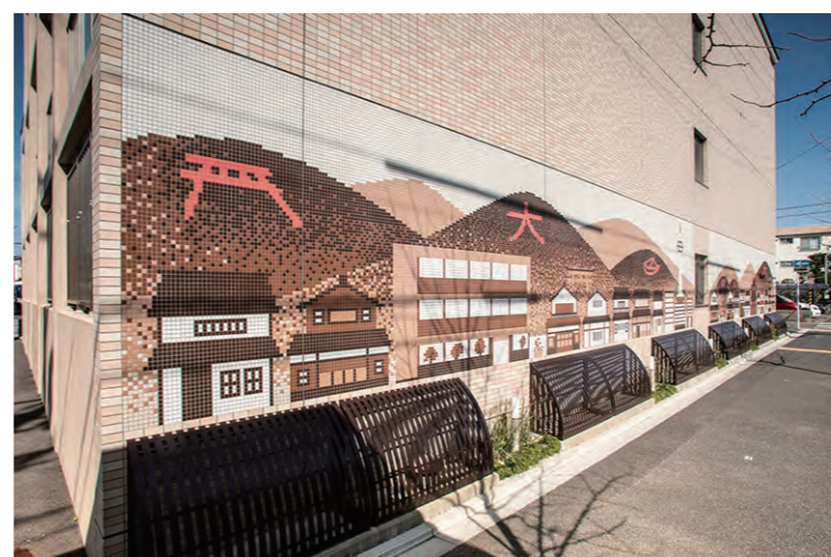
外装壁面コーナー部
