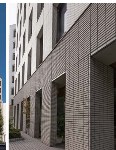
東側低層部外壁
