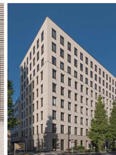
南西側全景外壁
