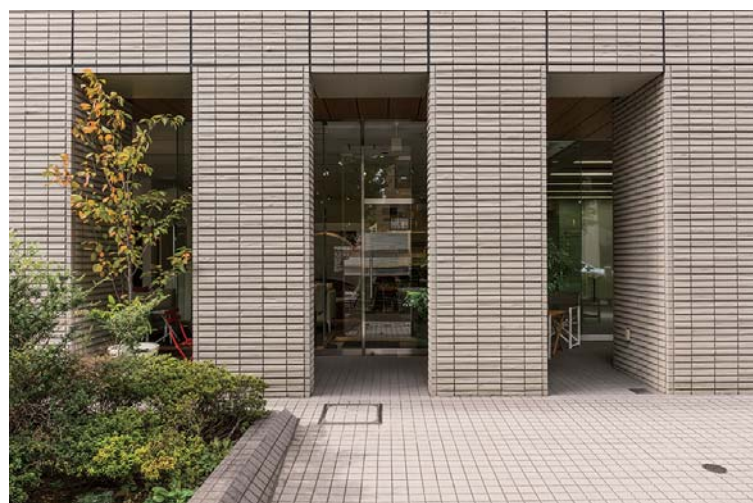
東側低層部外壁
