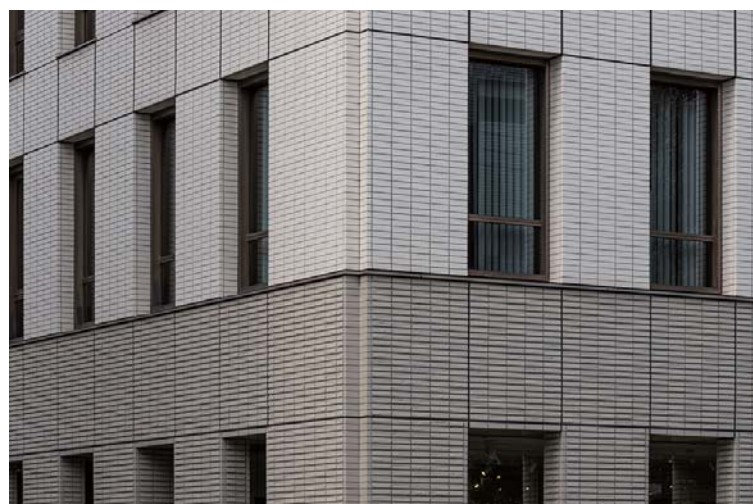
中低層部外壁
