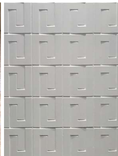
トイレ アクセント壁タイル
