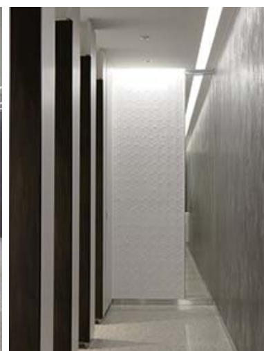
2Fトイレ アクセント壁タイル
