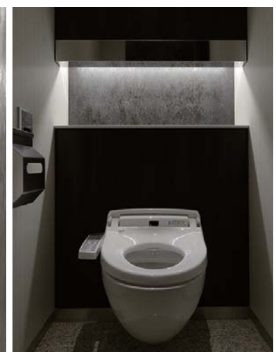
2F トイレブース 内壁・陶板
