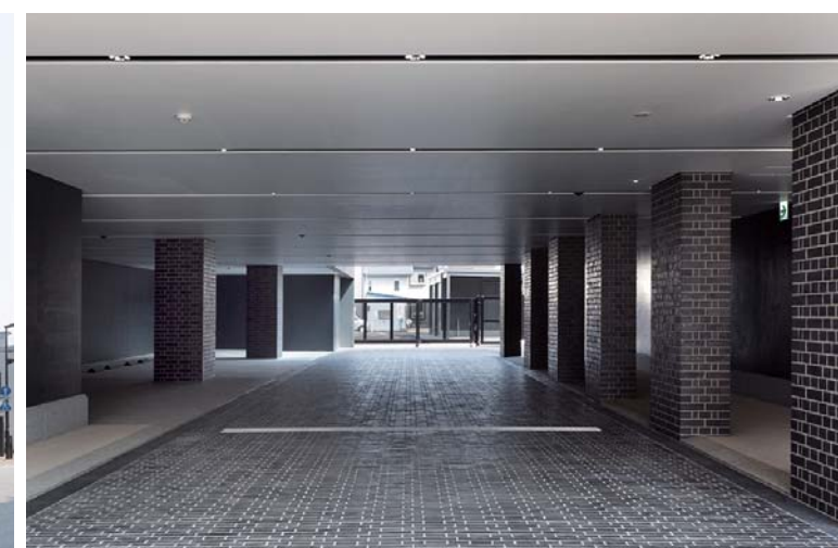
柱まわり外装壁面、車路外装床面
