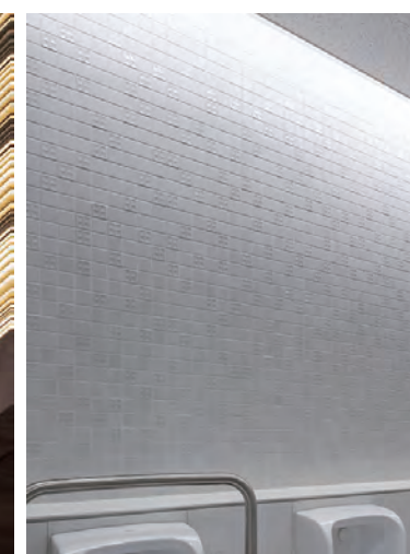
トイレ小便器まわり内装壁
