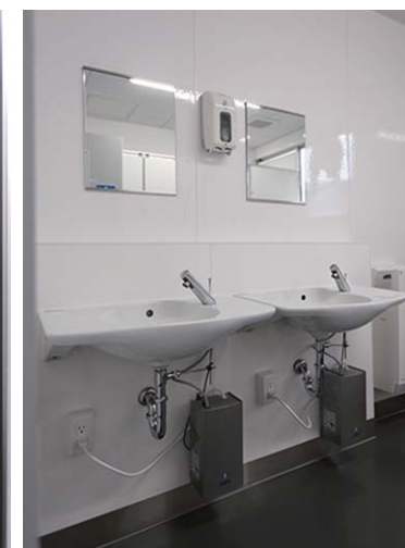
清掃性に優れたシンプル形状&壁掛式の小便器。尿だれを考慮した汚垂石を便器下に設置することで、より床の掃除がしやすくなっている。洗面器に採用した加温自動水栓は、必要なときだけ必要な水温まで瞬間的に加温して供給する手洗いシステムで、節電と節水に貢献している。
