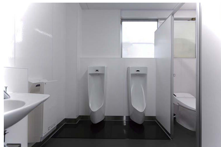
清掃性に優れたシンプル形状&壁掛式の小便器。尿だれを考慮した汚垂石を便器下に設置することで、より床の掃除がしやすくなっている。洗面器に採用した加温自動水栓は、必要なときだけ必要な水温まで瞬間的に加温して供給する手洗いシステムで、節電と節水に貢献している。
