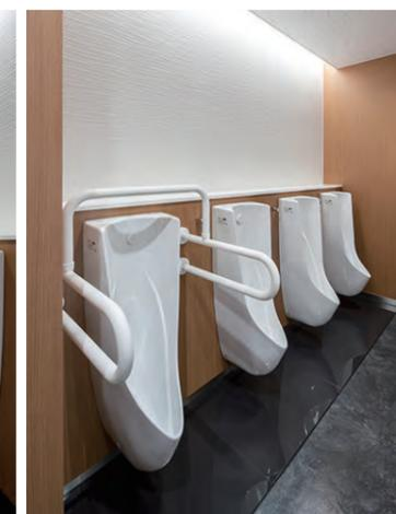
女性用トイレとは異なる柄のエコカラットプラスを施工。黒系の床が空間を引き締めている。大便ブースは、仕切りを床から天井まで伸ばすことで上下の隙間をなくし、安心して利用できる個室となっている。洗面の棚や小便器ライニングなど、手荷物置き場も確保。小便器下の磨きタイプの黒い御影石は高級感があり、清掃性も高めている。
