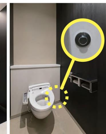
順光で顔全体が見やすく映り込みも少ないフロント照明付の個別タイプの鏡を設置した洗面や、天井まである小便器間のパーティションなど、プライベート感や快適性が配慮された室内。小便器・大便器ともに床の清掃性が高い壁掛けタイプを採用し、小便器下に汚垂石を設置。停電時も便器洗浄できる停電時操作ボタンを備えている。
