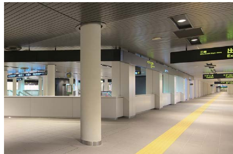
連絡通路全景
