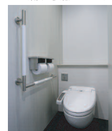
大便器ブース /手すり
