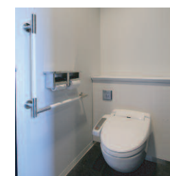
大便器ブース / 手すり
