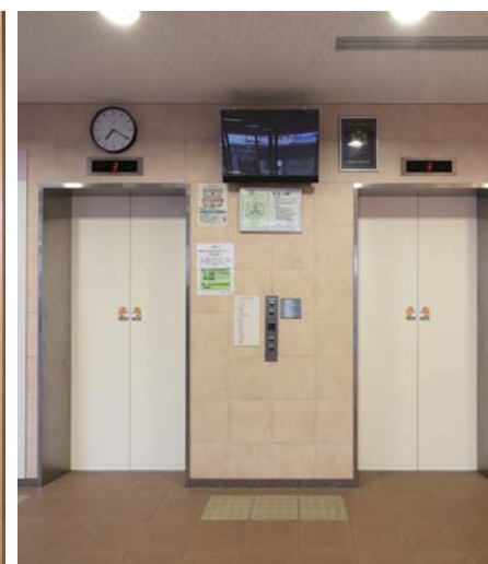
エレベーターまわり
