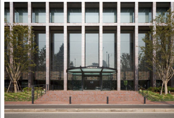
1F外部からのテラコッタブロックの隔壁 (日中)
