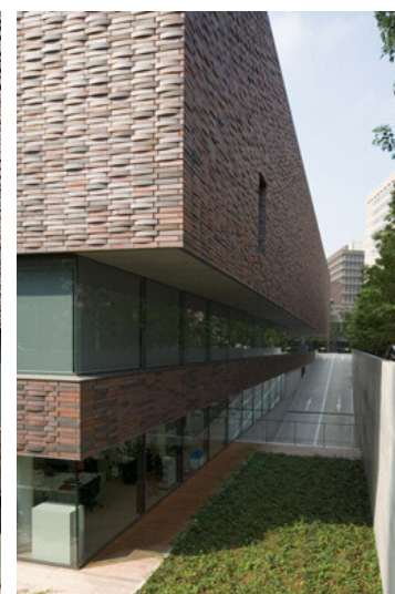
外観全景 南東側
