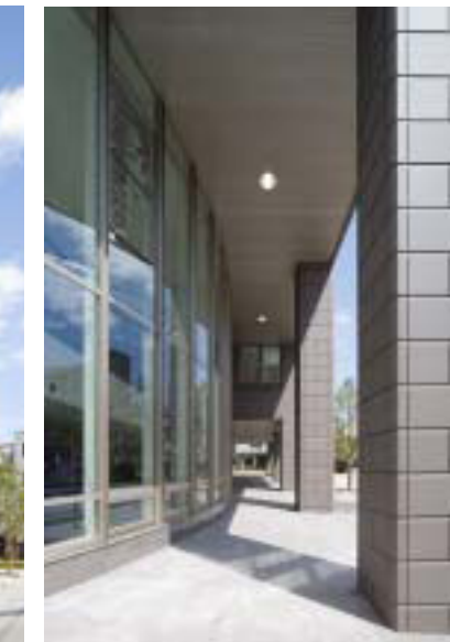
南西側柱周り
