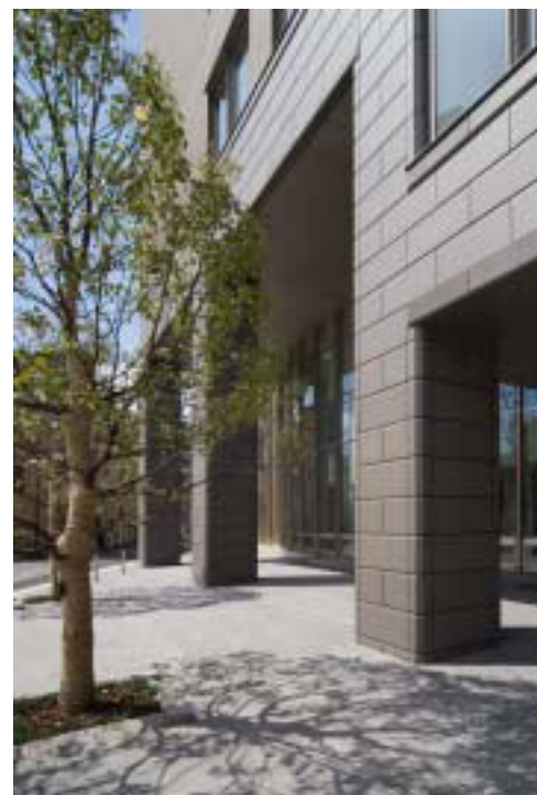
南東側柱回り
